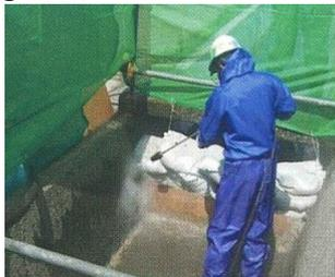
コンクリート下地面の脆弱部、汚れを除去します。
