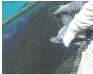
2倍液に希釈したRS養生剤を散布し、最終コテ仕上げをします。
