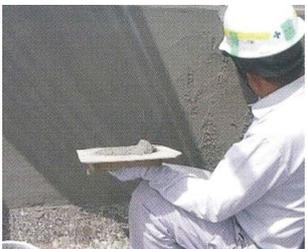
混練後のサンユモルタルをスクイズ式ポンプで圧送し、吹付けます。コテ塗りによる施工も可能です。
